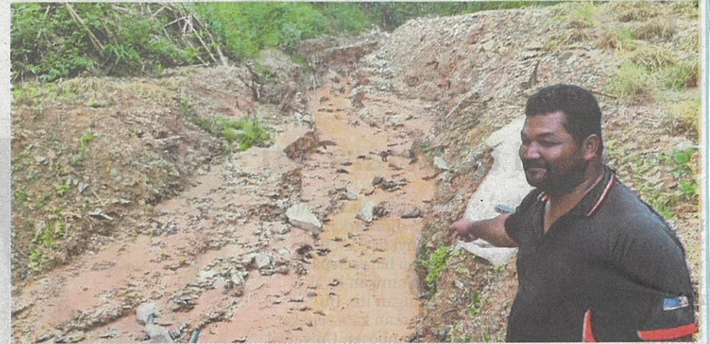
RIANG menunjukkan aliran air dari hakisan tempat tadahan air bukit yang berselut.
