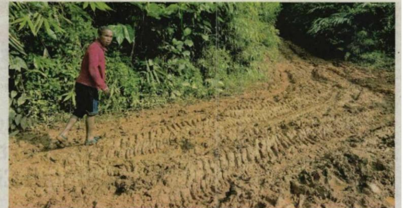
SEORANG penduduk Orang Asli menunjukkan keadaan jalan perhubungan masuk ke kawasan kampung mereka yang rosak akibat hujan di Gua Musang, Kelantan. - UTUSAN/AIMUNI TUAN LAH
